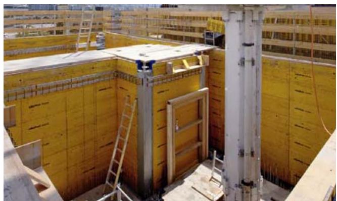
Titelbild: 'Ziel vor Augen', Juli 2010 oben: Betonkern mit Kletterschalung mitte: Wochentakt 1 Stockwerk unten: Schwing-Betoniermast
