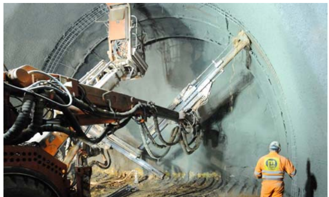
Titelbild: Innenausbau Verschalung oben: Sicherung mit Spritzbeton mitte: Innenausbau: Fertiger für Drainage-Packung unten: 3-armiger Bohrjumbo mit Ladekorb
