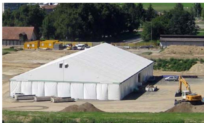
oben: Rodung und Triage-Aushub Zielhang mitte: Rückbau und Bodenabtrag Scheibenstand unten: Materialvorbereitung in Schutzzelt
