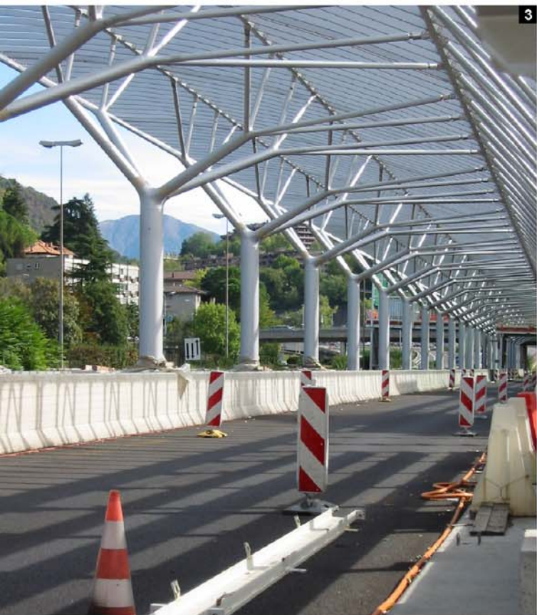
1. Fondazione tra A2 e viale Galli 2. Getto fondazioni lungo A2, Balerna 3. New Jersey e carpenteria metallica, viale Galli
