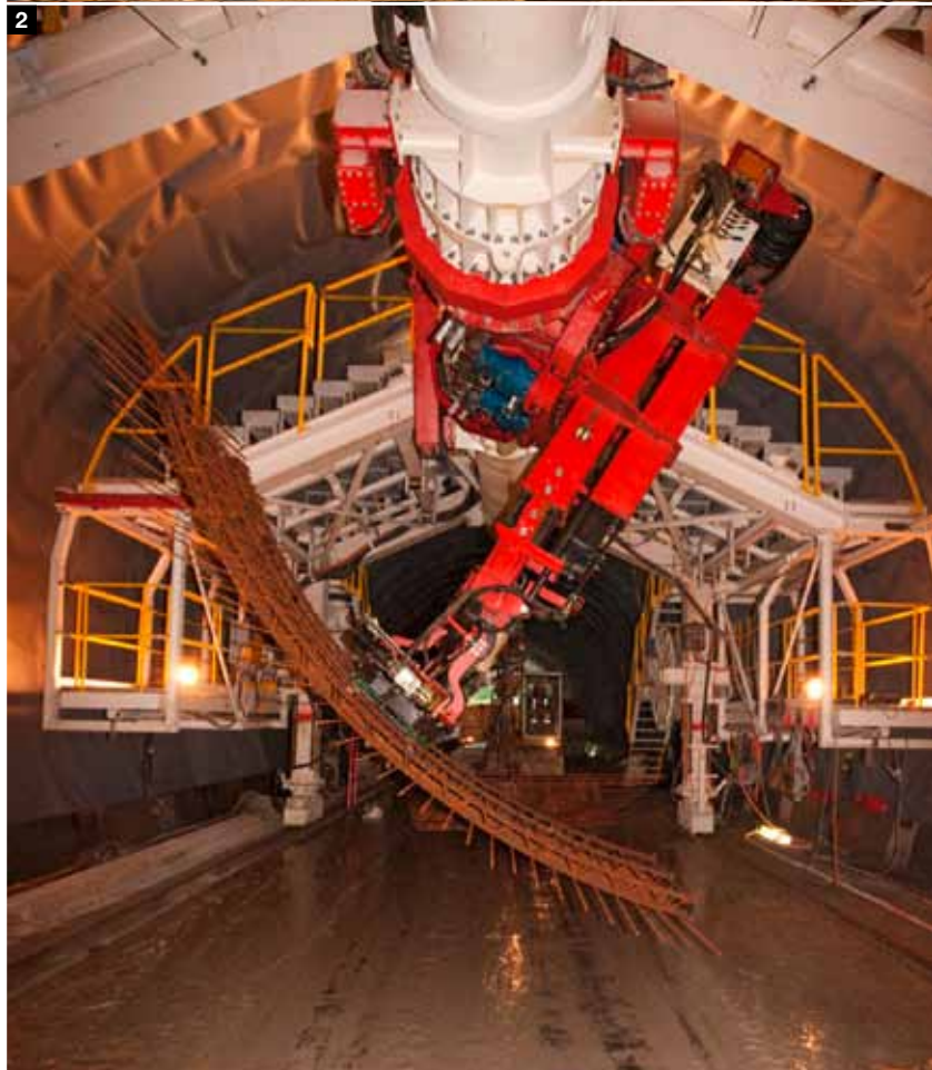
Titelbild: Kernbauweise mit Ausbruch in Teilquerschnitten 1. Ausbruch mit Teilschnittmaschine 2. Bewehrungskorb-Versetzung (Marti-Entwicklung)
